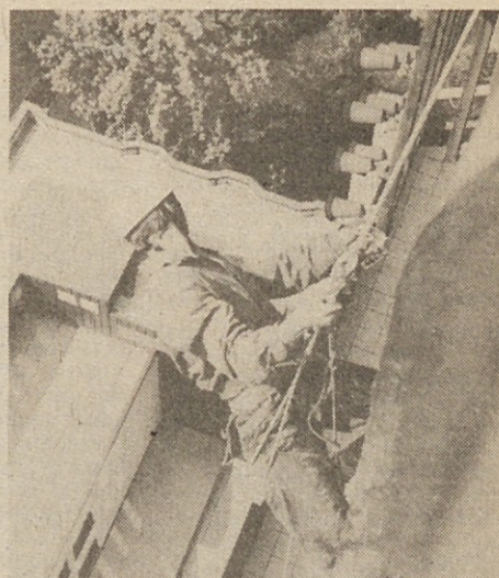
Levji delež pri zamenjavi nosilne konstrukcije so opravili alpinisti »himalajci.«
