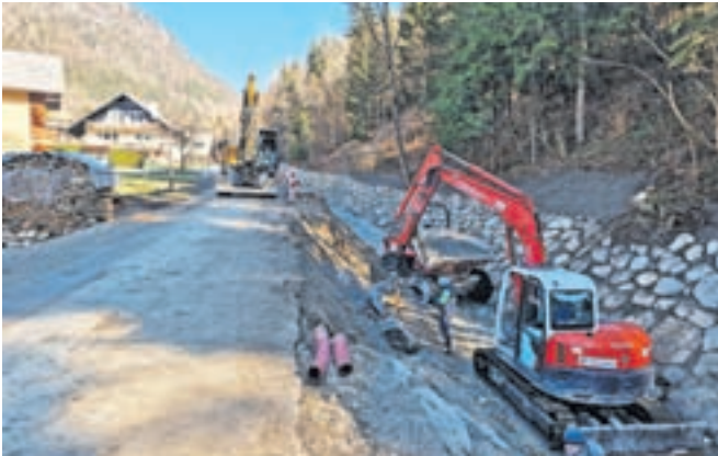
Sanacija vodotokov / Foto: Občina Kamnik
