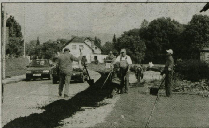
Zaključna dela po zamenjavi vodovoda v Preserjah na Pelechovi ulici.
