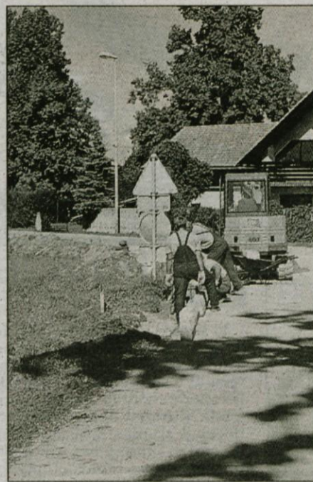
V Mačkovcih poteka delna obnova cestišča, zgrajen pa bo tudi nov pločnik
