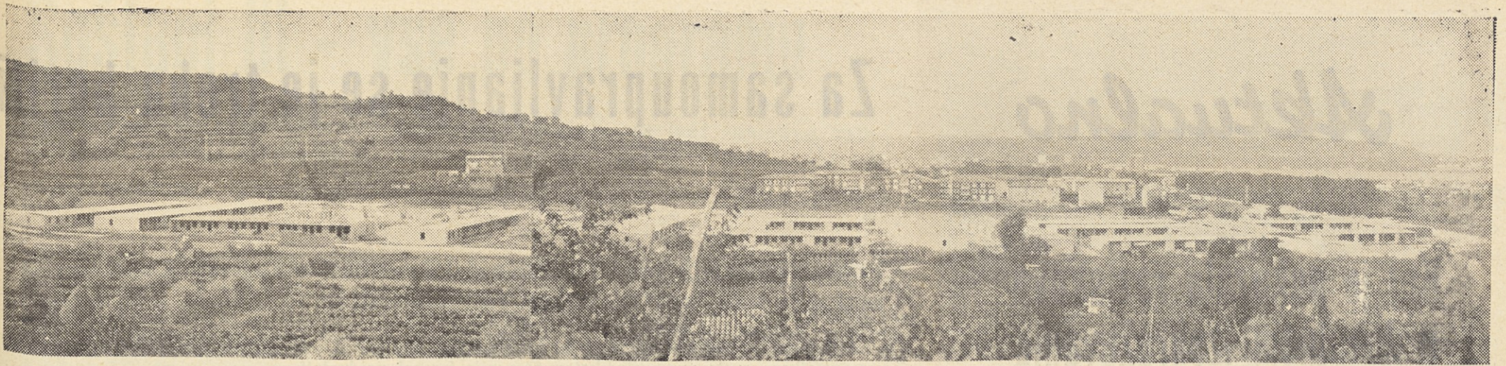
STANOVANJSKO NASELJE OLMO V KOPRU — Tu gradimo 330 stanovanj, do konca letošnjega leta bo vseljenih 170, dela pa bodo končana julija 1970
