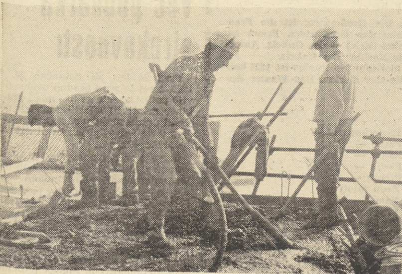
Betoniranje na hotelu »Jadranka«
