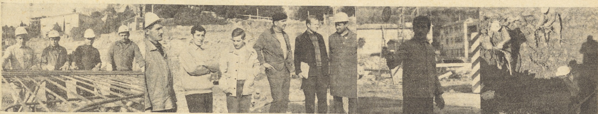
OD LEVE PROTI DESNI: Teren je zelo težaven, brez miniranja in vrtnih kladiv ne gre — Stop, prednost imajo avtomobili Gradisa — Vodstvo poslovne enote mariborskih graditeljev — Zelezokrivce čaka še veliko dela
