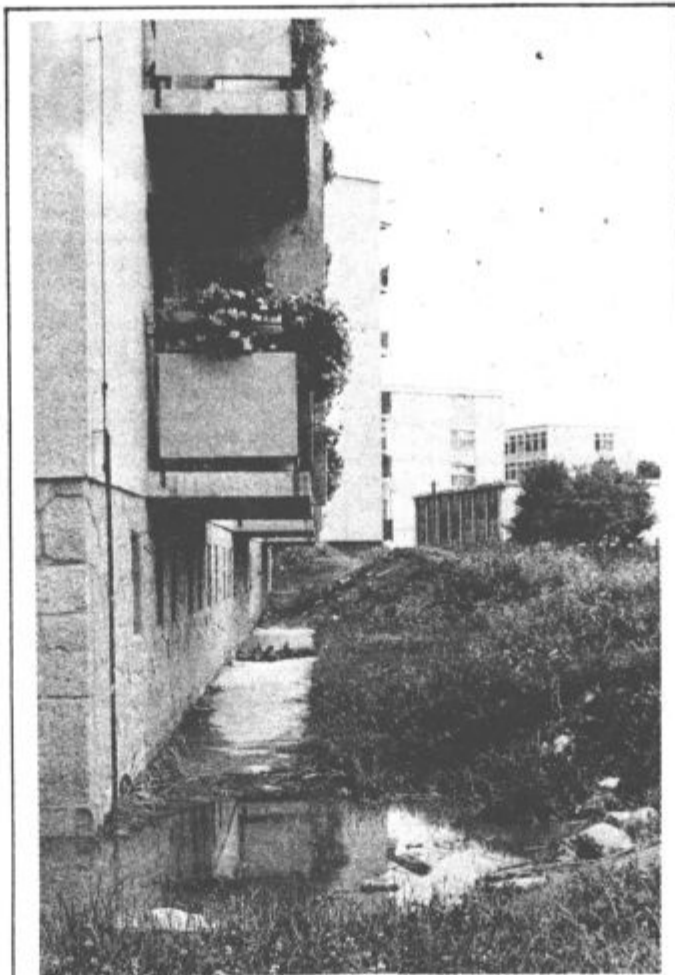
Te dni smo dobili v naše uredništvo pismo in fotografijo prostora ob Jenkovi cesti v Velenju, kjer je bilo včasih otroško igrišče. Letos so tam začeli graditi glasbeno šolo. Pred stanovanjske zgradbe ob Tomšičevi cesti so narili kupe zemlje, ki jo je že prekril plevel. Večkrat je bilo stanovanjem obljubljeno, da jo bodo odstranili, vendar je vse doslej ostalo le pri obljubah. Ob deževju, tega nam letos poleti resnično ne manjka, nastajajo ob stanovanjskih zgradbah mala jezera.
