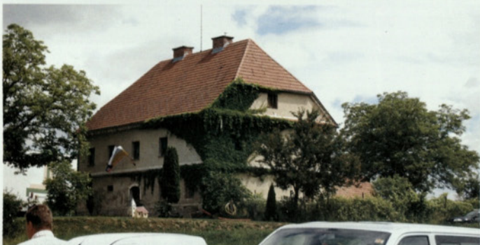
Zgradba župnišča je v notranjosti temeljito prenovljena.
