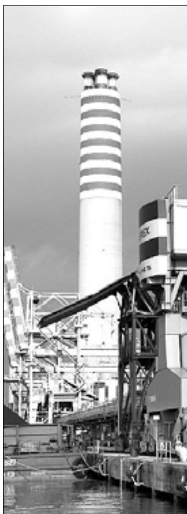
Dimnik tržiške termoelektrarne
