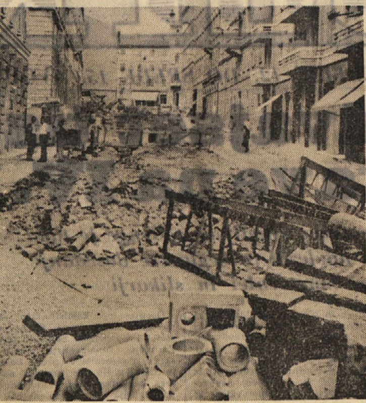
Po trzih Sansovino in Vico ter bližnjih ulicah, ki so bile toliko časa razrile, je prišla sedaj na vrsto obnovitev kanalizacije in raznih drugih napeljav ter cestišča v Ulici Bramante, tako da je sedaj na tem odseku precej oteženo prehod vozil in pešev. To je še toliko bolj nerodno, ker je sedaj v turistični sezoni mnogo večji promet kot običajno, ker je mnogo obiskovalcev Sv. Justa
