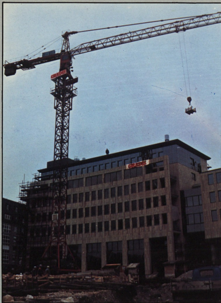
Gradnja poslovno trgovskega objekta, ki ga v ljubljanski soseski Zupančičeva jama gradi GP Ljubljana, gre proti koncu.
