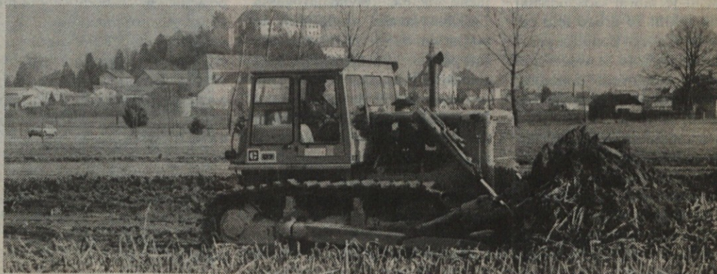
Odrivanje humusa na gradbišču apartmajskega naselja v Ptujskih toplicah se je začelo 26. novembra letos.
