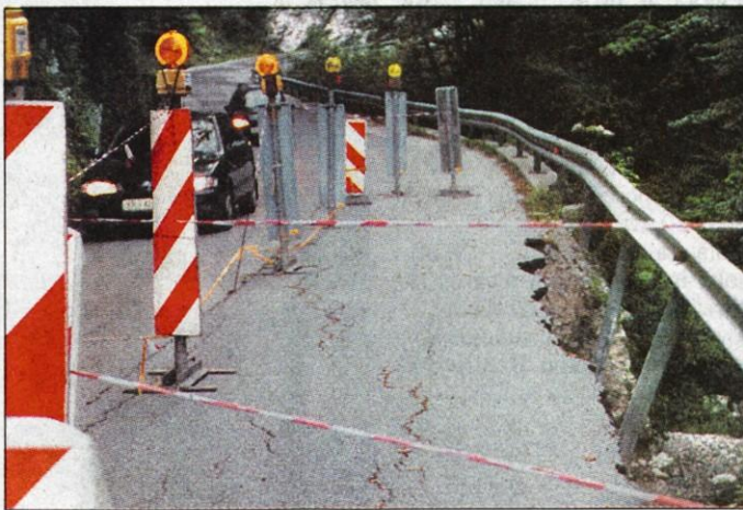
Najbolj nevaren odsek ceste skozi Korita: prihodnje leto bodo zgradili oporni zid.
