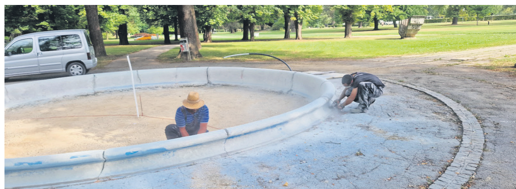
Prenova nekdanje fontane v celjskem parku. Ker je bila temeljna plošča bazena popolnoma preperela, je bilo treba zamenjati celotno podlago in jo zaščititi z vodoodpornim premazom. (Foto: arhiv MOC)
