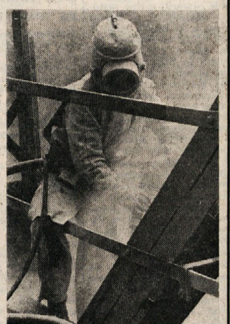
CENTIMETER ZA CENTIMETROM — Desetletna rja le počasi popušča, čeprav se je delavec nadležno spravljal z najsodobnejšo opremo.
