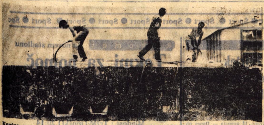
Končno so začeli podirati bunker ob cesti JLA v Kranju (v bližini novega gasivskega doma)
