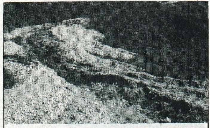
Tako se ob neurju cesta preseli nekaj niže. Če bi poskrbeli za odvodne kanale na vsakih 15 do 20 metrov voda ne bi postala hudourni ... Potem se pa zgodi, da cesto odnese ...
