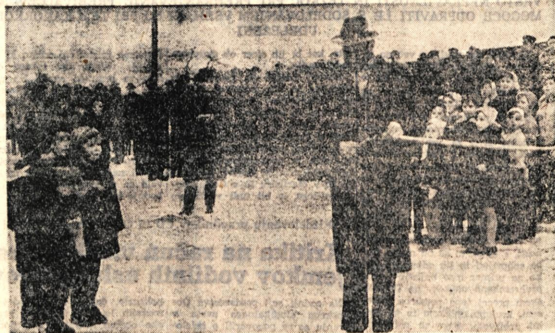
Na občinski praznik — 18. december — so v Skofji Loki izročili prometu kar dva mostova. Vrvico na betonskem mostu čez Sušico je prerezal podpredsednik OLO Kranj Sveto Kobal. Ta most je zgradilo gradbeno podjetje Gradis v rekordnem času. Prehod čez most pri tovarni Šešir pa je odprl ljudski poslanec Lado Logar. Most pri tovarni Šešir je delo gradbenega podjetja »Tehnik« Skofja Loka. Na sliki: Tovariš Sveto Kobal je prerezal vrvico
