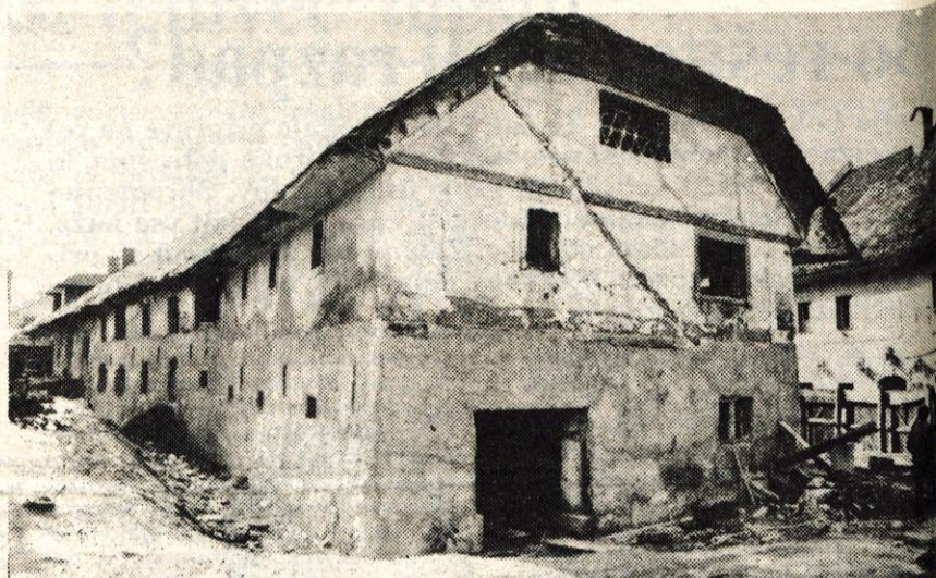
Kranj — Stari Gaštelj je dolga leta kazal kaj klavno podobo. Če bi bila Sava ne popravljala strehe tudi na nekdanjem gospodarskem poslopiju, bi se bil ta že davno zrušil. Letos pa se je Sava lotila temeljite prenove. Gaštelj, obe veliki zgradbi, gospodarsko poslopije in hiša, v kateri je danes gostilna, bosta obnovljeni do leta 1989, v njih pa bodo lepa moderna delavska restavracija, skladišni prostori in drugi večnamenski prostori. — D. Dolenc — Foto: F. Perdan
