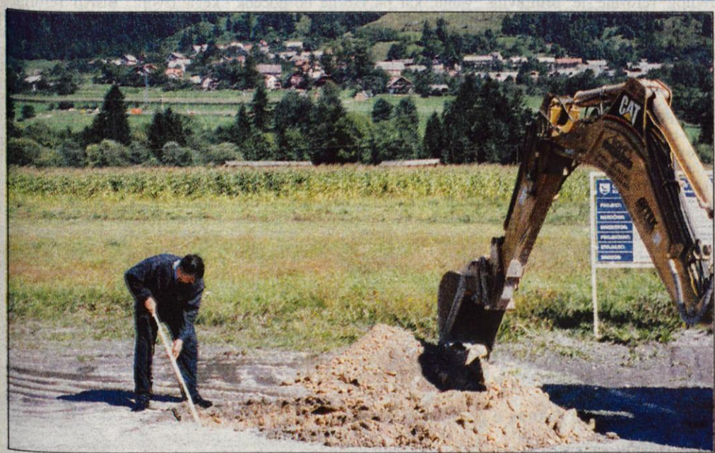
Začetek graditve kanalizacijskega omrežja v Kranjski Gori
