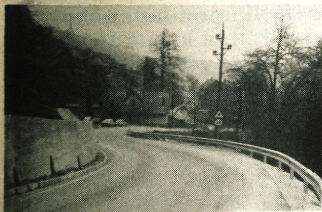
Lancovo — Pot iz starega dela Radovljice na Lancovo je iz Linhartovega trga proti nadvozu nad železnico zelo ozka in nevarna. Zato so se odločili, da speljejo novo cesto do mostu čez Savo na Lancovem. Ta cesta je v spodnjem delu že popravljena, v zgornjem delu pa je še makadamska. Ker pa dela še niso zaključena, je na njej hitrost omejena. — B. B.
