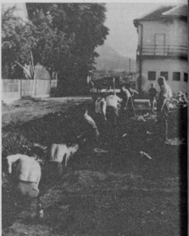
Takole so začeli s delom za novo keglišče, s udarniškim delom zanesenjakov.
