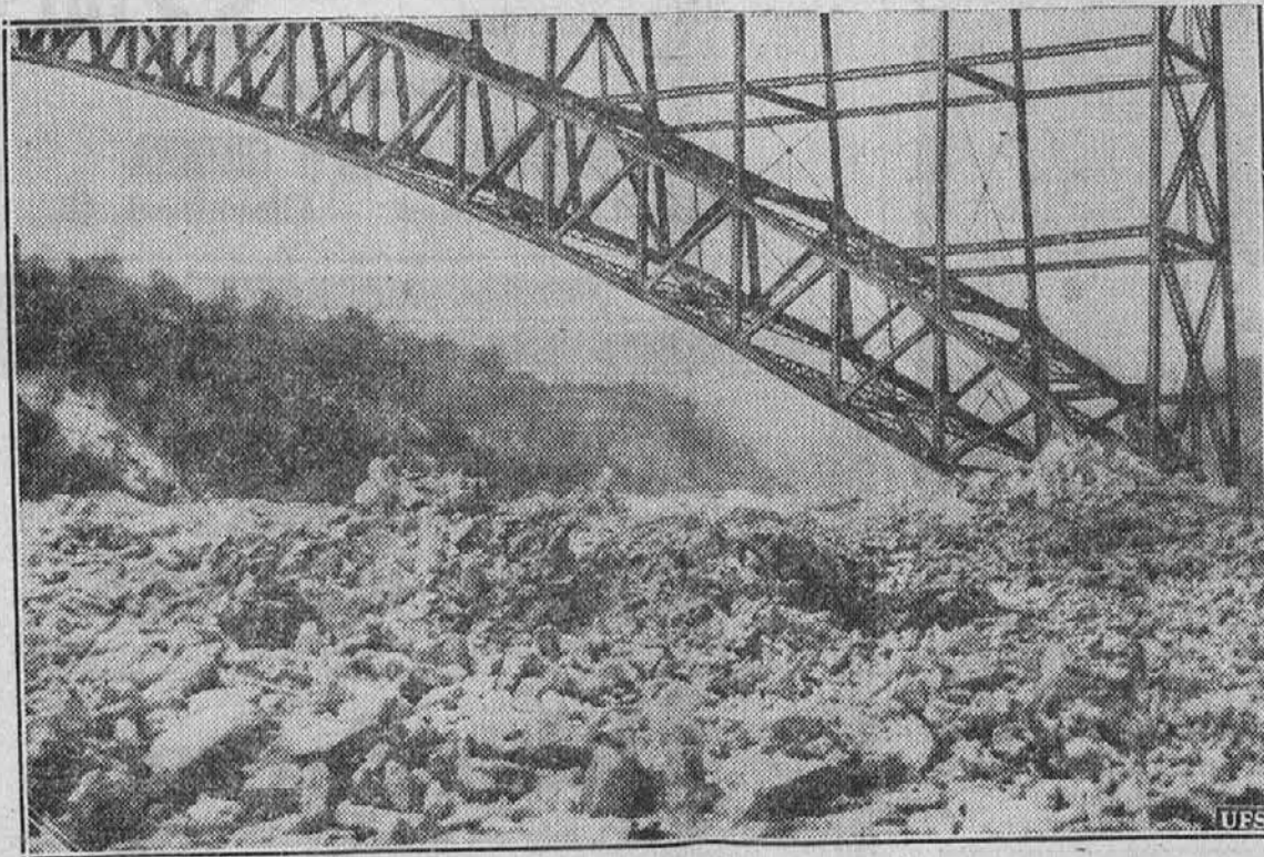
Ogromna masa ledu, ki se je nabrala pri temeljih mostu čez Niagarske slapove. Vse od silnega pritiska ledu, se je ta slavni most zrušil. Nekaj delavcev, ki so hoteli odstraniti led, se je v zadnjem trenutku rešilo.
