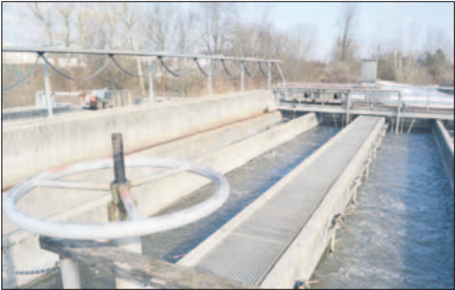
Trenutna čistilna naprava na Tojnicah ponuja zgolj mehansko čiščenje.
