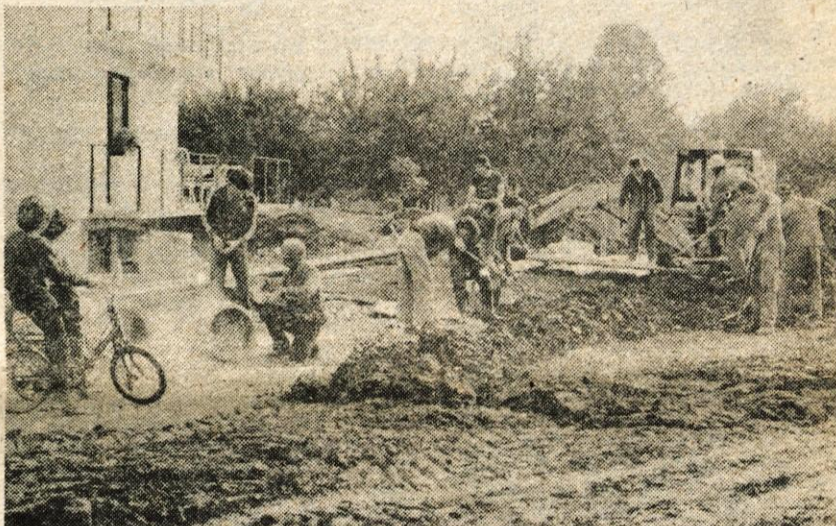
Voda ne bo več vdiral v kleti — Hude težave so imeli krajani spodnjega dela Predoselj z meteoritnimi vodami, ki so jim ob vsaki večji moči vdirale v kleti. Pa se je petindvajset gospodarjev hiš v tem koncu Predoselj odločilo, da naredi kanalizacijo za odvod meteoritnih voda. Na 650 metrov dolžine bodo skopali globoke kanale, položili cevi, zravnali zemljo; pa skoraj ne bo videti, da so razkopavali po vasi, huda vodna nadloga bo pa le ugnana. Okrog 600 starih milijonov bo vredna investicija, ko bo gotova. — Foto: D. Dolenc
