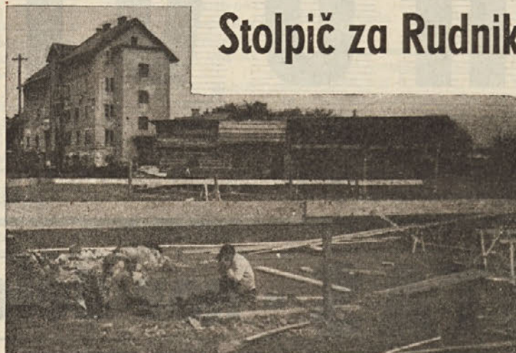
Delavci SGP »Zidar« so že izkopali temelje 20-stanovanjskega stolpiča za Rudnik. Stolpič, ki bo stal v Šeškovi ulici, bo dograjen predvidoma do prihodnjega 3. julija, dneva rudarjev. Z dograditvijo tega stolpiča pa še vedno ne bo rešen stanovanjski problem kočevskih rudarjev.
