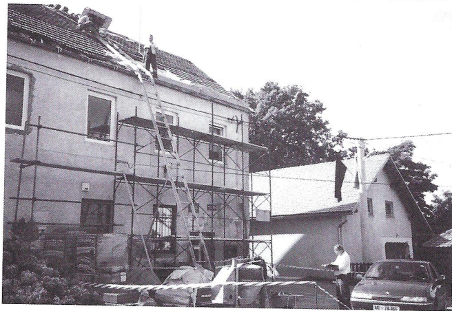
obnova strehe na občinski zgradbi. Obnovo je izvajalo gradbeno podjetje Peter Lamut iz Selnice ob Dravi.
