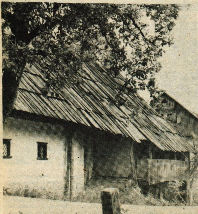
Najstarejša domačija v Studorju v Bohinju propada; do leta 1985 ne bo denarja za njeno obnovo ...
