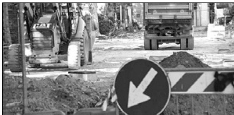
Gradbišče na Verdijevem korzu
