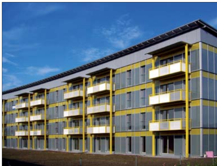
Stanovanjski blok v Solarcity
