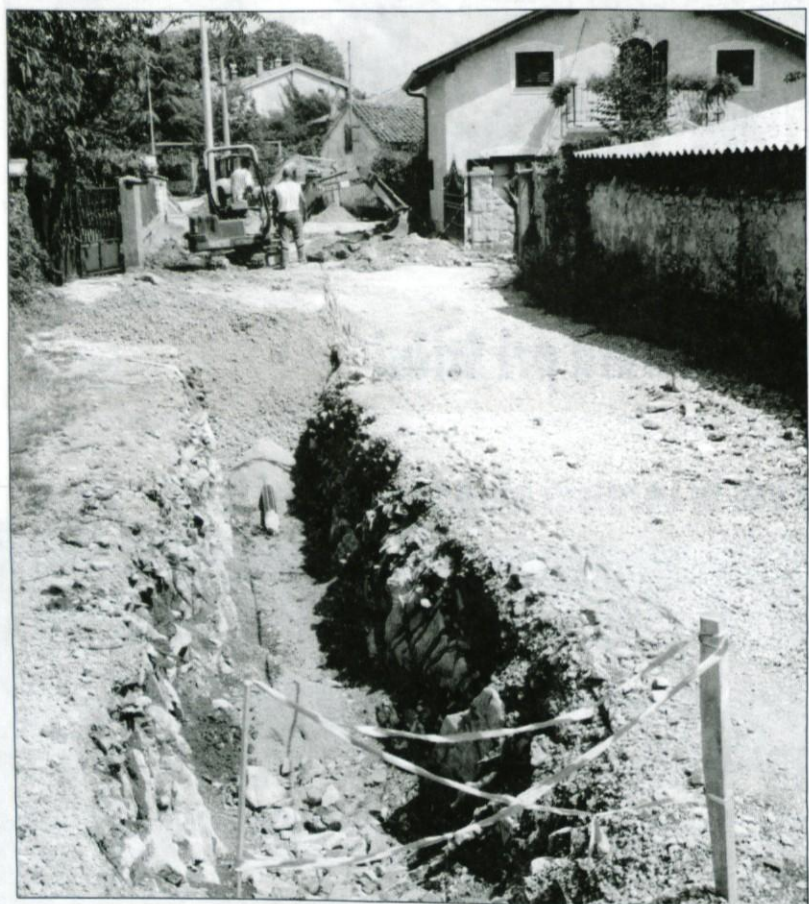
Do leta 2012 se bo marsikje po občini postavilo kanalizacijsko omrežje.
