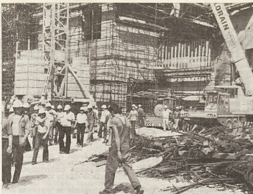
Člani delovnega kolektiva »Bytostav« so si z zanimanjem ogledovali gradnje jedrske elektrarne v Krškem
