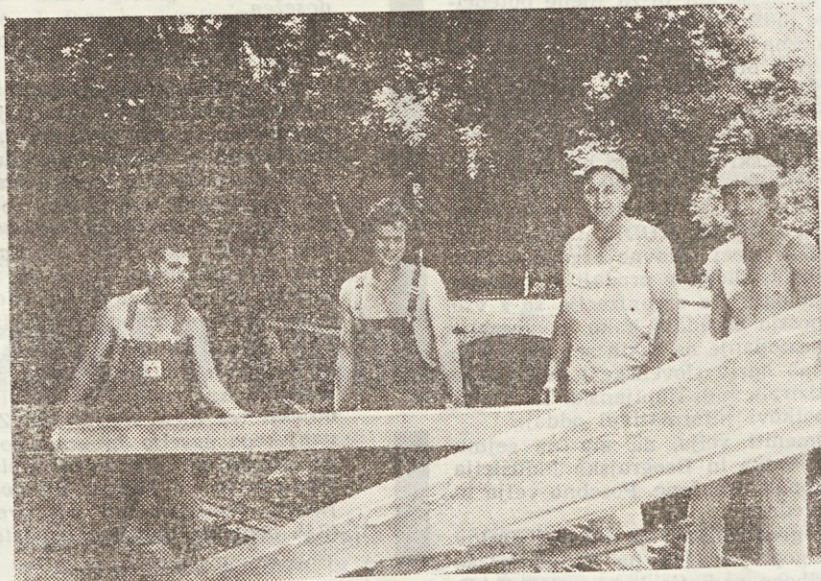
Delavci na gradbišču Karlovškega mostu
