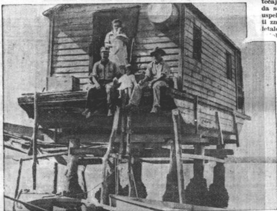
STAVBE NA KOLEH — Se danes živijo predstavitelji nekaterih krajev v Pacifiku, ki so zgrajeni na kolih. Ta slika je bila napravljena na otoku Chokoloskee v Mehškem zalivu
