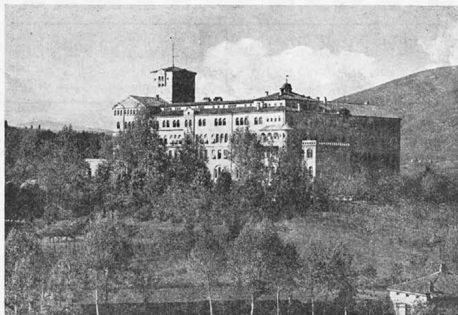
Pogled na mogočno stavbo goriškega semenišča
