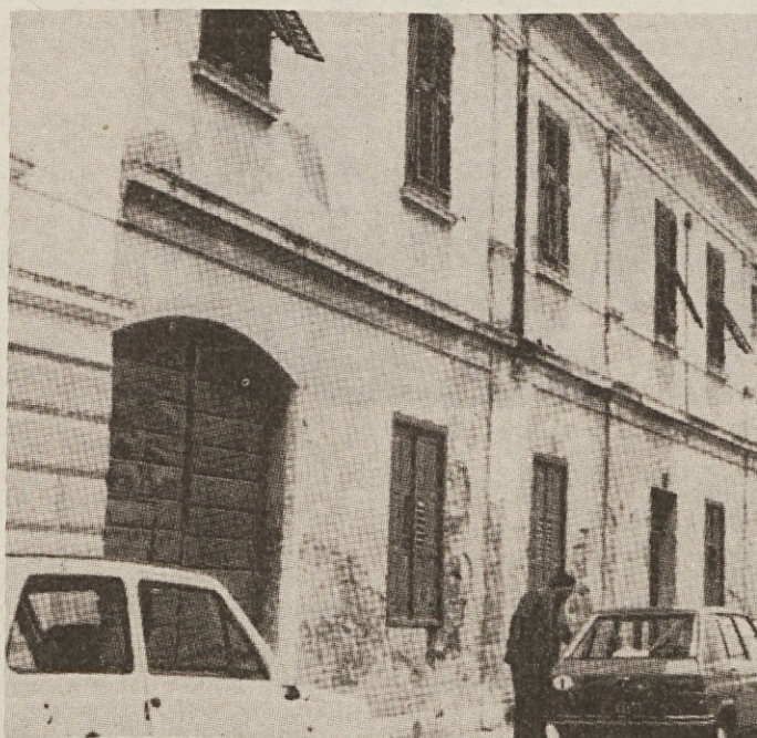
Stavba v Ulici Barzellini (danes Ulica Cascino) kjer je Politično društvo Sloga odprlo leta 1892 zasebno slovensko osnovno šolo. Stavba je danes zapuščena in potrebna temeljite obnove
