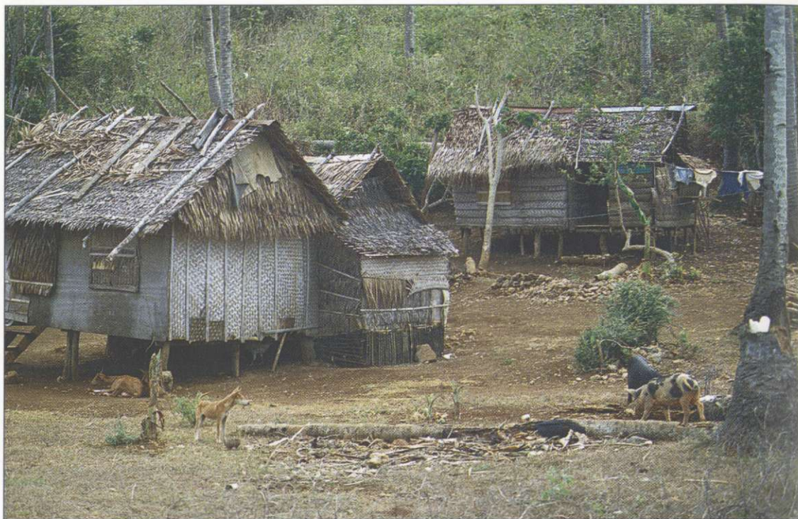
Slika 3: Skromne koče podeželskega prebivalstva so zgrajene večinoma iz bambusa, za vezavo pa služi predvsem les kokosovih palm. Hiše so na kolen, s čimer so vsaj deloma zavarovane pred poplavam. Vendar šibka konstrukcija pogosto ne more kljubovati močnim vetrovom, zato so njihove posledice lahko uničujoče. Med hišami se pasejo domače živali. Prašiči so dokaz, da smo v krščanskem delu države. (Foto: D. Kladnik.)
