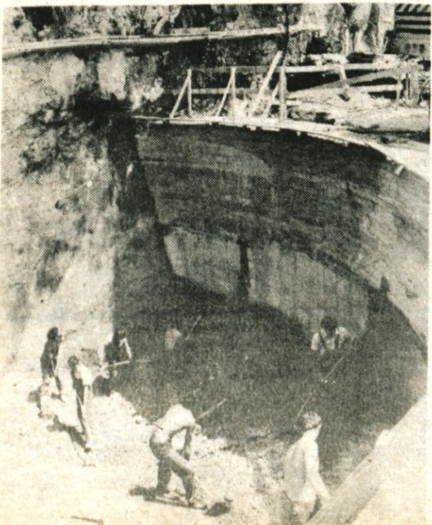
Pred začetkom glavnih del je bilo najprej treba narediti cesto in urediti 100 metrov dolgo brežino desne brega pod jezo.
