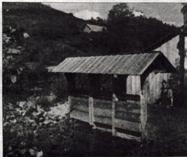
Tako sta izgledala žaga in mlin pred približno šestdesetimi leti. Posebnost je bila, da so bila vodna kolesa pod streho.
