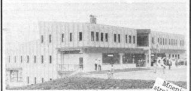
Tudi Prodajni center KK Šentjur smo zgradili. Mnenje strokovnjakov, da je to najboljša rešitev.
