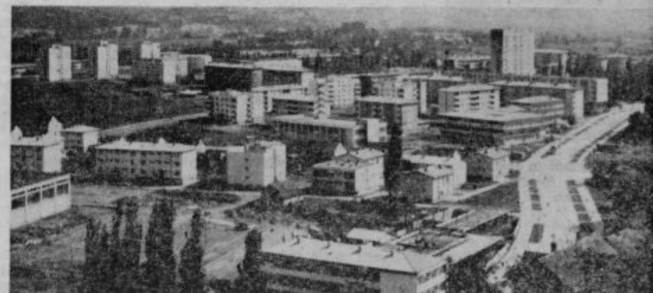
Skoro ves Doboj je nov, zgrajen je v ravnini in arhitektonsko dokaj zaokrožen.
