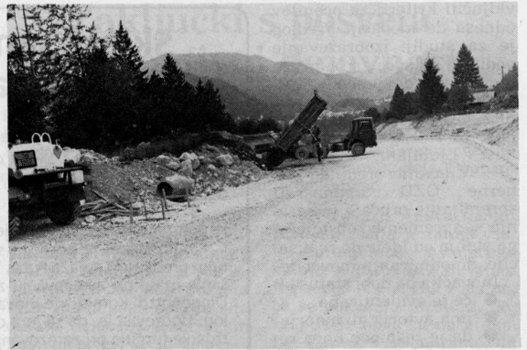
Dela na bohinjski cesti se bližajo koncu. Po zagotovilih izvajalcev (CP Kranj) in investitorja (Skupnost za ceste Slovenije) bo cesta nared pred zimo. Otvoritev bo predvidoma za 29. november.
