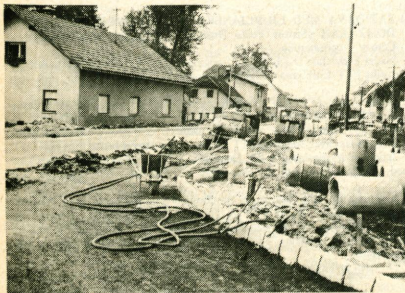
Usahnila je turistična sezona, končuje se maratonsko razkopavanje ceste na Viru. Z dograditvijo kanalizacijske mreže, pločnikov in razširjenega cestišča ter poslovnih prostorov Ljubljanske banke in novega silosa ŽITA bo krajevna skupnost dobila lepšo podobo živahnega in razvitega kraja. Foto Roje
