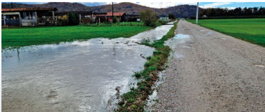
Prikaz izliva vode proti vzhodu Bukovice do objektov iz kanala zaradi zamaškov v nepretočnih cevnih prepustih.
