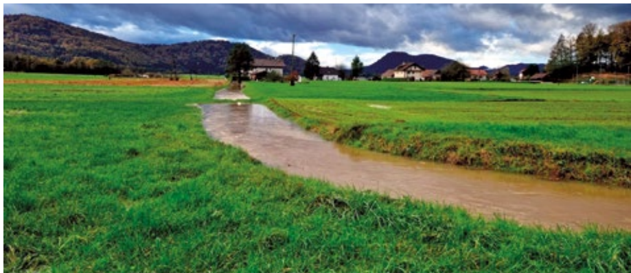
Prikaz zamaška pred nepretočnim cevnim prepustom v Utiku in posledično poplavljanje in ogrožanje objektov in kmetijskih površin.
