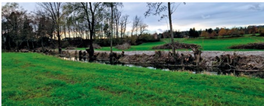
Temeljito očiščeno vejevje in podrta drevesa ter poglobljena struga vodotoka Poljšak.
