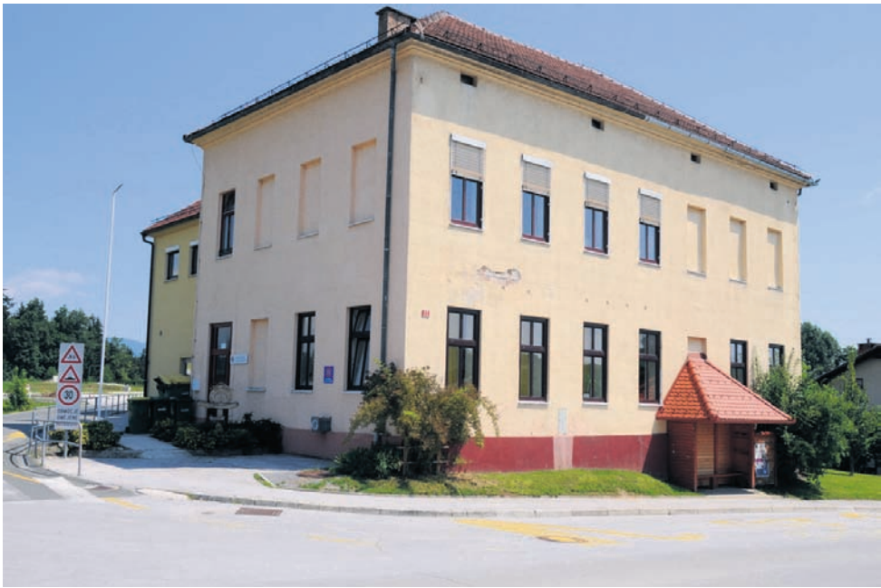
Tako kot ostale obnovljene stavbe podružnična šola na Blagovni navzven ne bo zelo drugačna, bodo pa kakovost bivanja in pogoji dela v njej na precej višji ravni.
