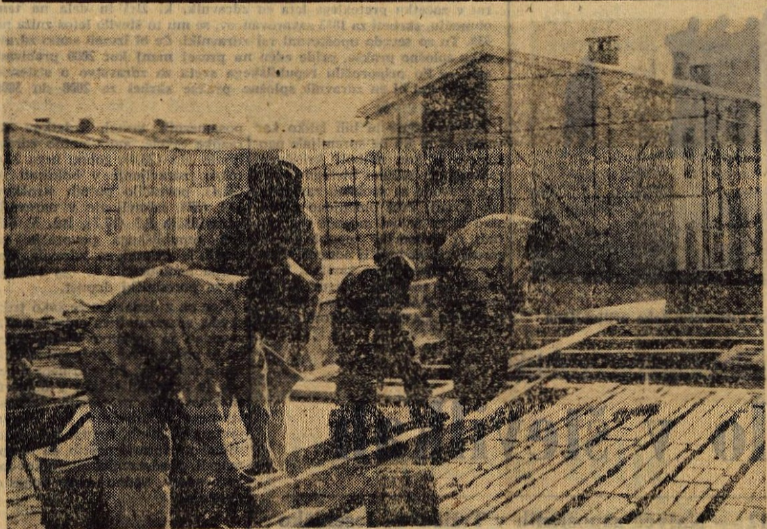
Kakor hitro je popustila zmrzal, so oživila dela pri gradnji stanovanjskih hiš v Radovljici. Na tem mestu — med cesto in kopalščem, kot kaže slika, morajo dokončati tri bloke. Hkrati pa bodo začeli z gradnjo še petih večjih hiš s po 16 stanovanji (into zadaj za stavbo občinskega ljudskega odbora)
