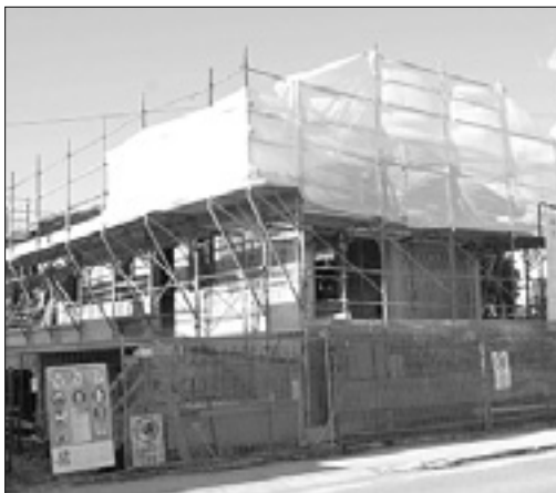
Gradbišče Butkovičeve domačije
