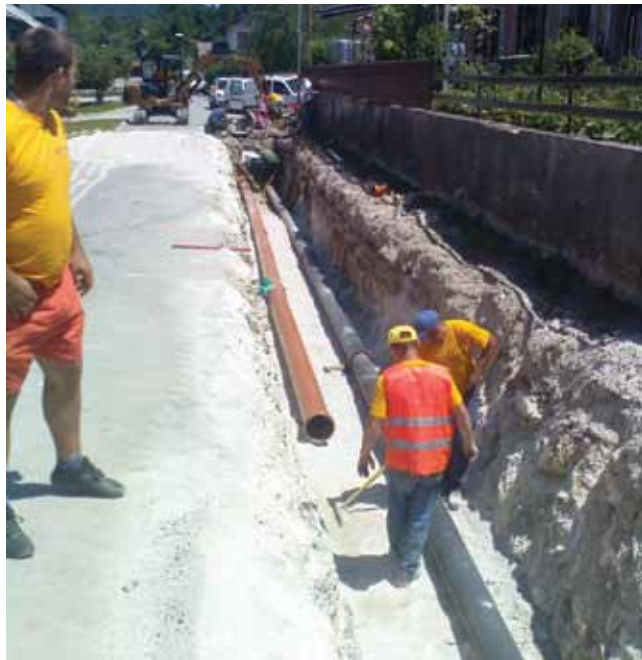
Lani so uredili vodovod in kanalizacijo na Stari cesti v Dolnjem Logatcu. (foto: KP Logatec)
