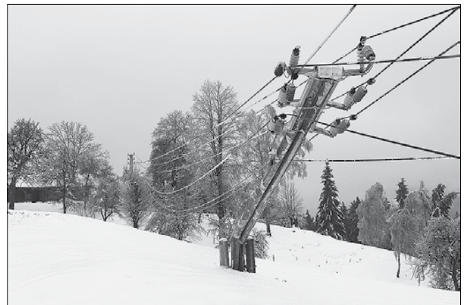
V podjetju Elektro Celje so se tudi zaradi žledoloma odločili, da v dveh letih uredijo zemeljski kablovod na relaciji Nazarje-Ljubno ob Savinji. (Fotodokumentacija EC)
