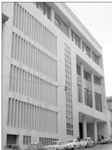
Pročelje Kulturnega doma
