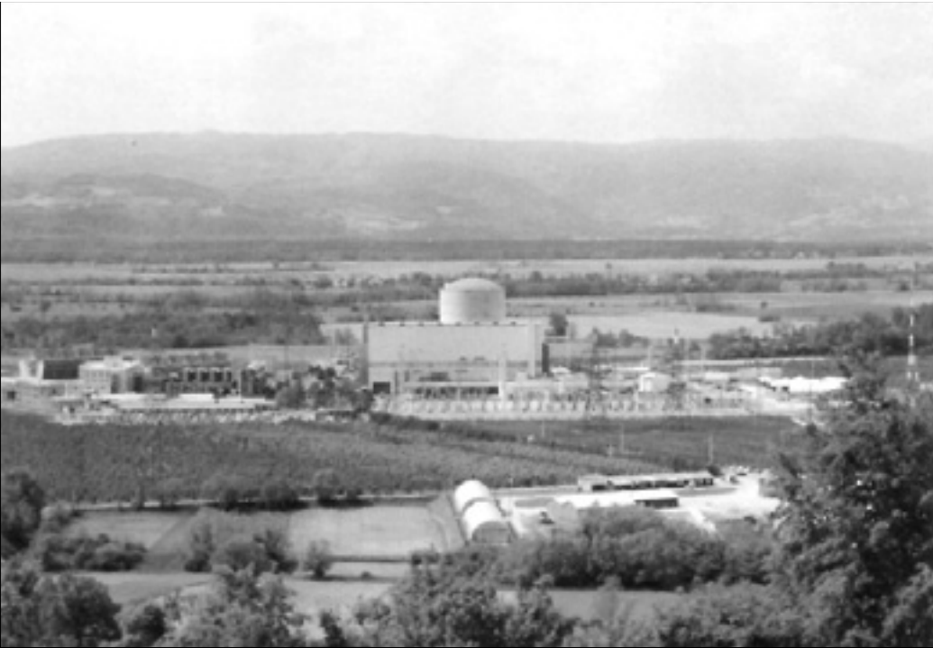
Jedrska elektrarna Krško je neprekinjeno obratovala rekordnih 510 dni
