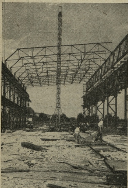
Namestitev veznikov z montažno iglo
