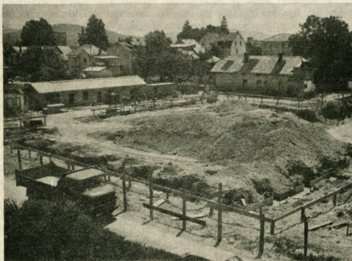
Končno so se začela dela na gradbišču osnovne šole Vencelj Perko
