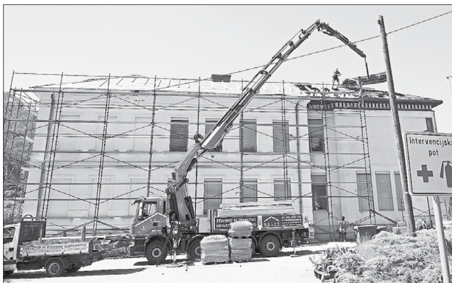
Krovska dela na stari stavbi gornjegrajske šole (foto: Štefka Sem)
